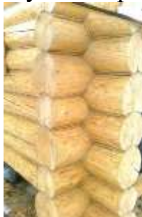
Рис. 1. Перевязка углов: рубка в обло (слева) и в лапу (справа).
