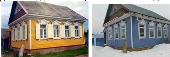
Рис. 28. Дом № 76\16, ул. Горького,
