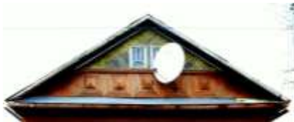
Рис. 6. Зашивка фронтонов. 50- 90-е гг. XX века в Велиже: вариант - з
