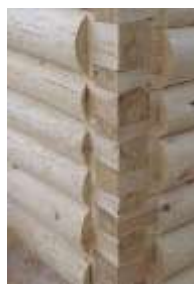
Рис. 1. Перевязка углов: рубка в обло (слева) и в лапу (справа).
