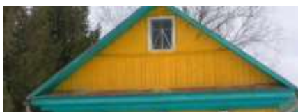
Рис. 4. Зашивка фронтонов. 50- 90-е гг. XX века в Велиже: вариант - е.
