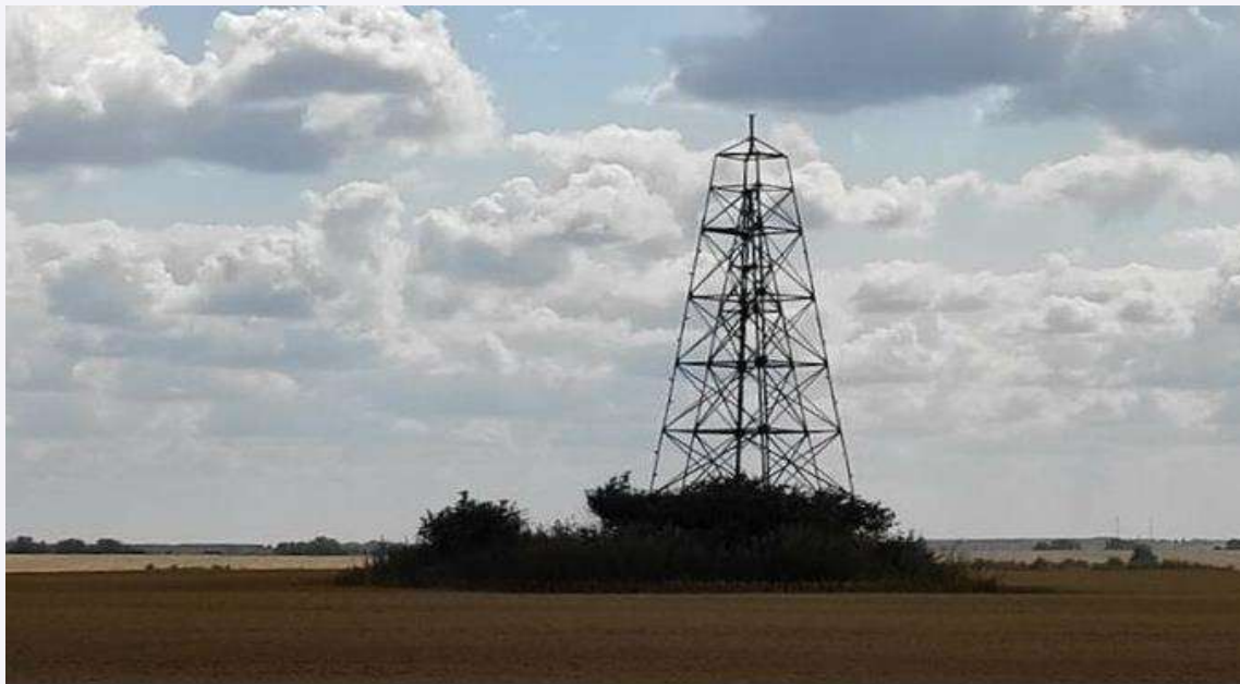
Современный (конец XX века) пункт триангуляции в Тульской области.
